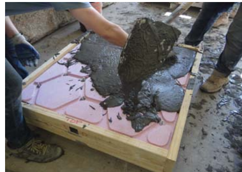
POURING OF STRUCTURAL WYTHE
